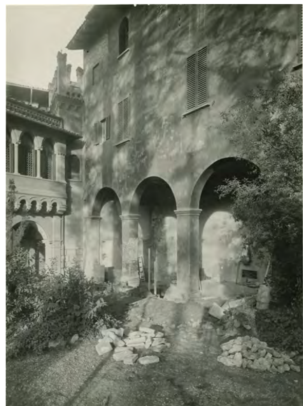
Fig. 4, fotografia dei Lavori per la costruzione della "cappella" ospitante la riproduzione del sepolcro di Albornoz, 1930-1932, Bologna, Archivio del Reale Collegio di Spagna.
