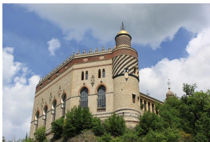
Fig. 6, Veduta esterna del Loggiato pensile e della torretta con la Sala Verde, Rocchetta Mattei, Grizzana Morandi, Riola di Vergato.
